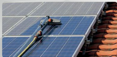
MYCIE PANELI FOTOWOLTAICZNYCH
