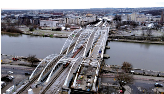
Widok z lotu ptaka na trzy nowe mosty kolejowe Fot. Piotr Hamanik PKP PLK
