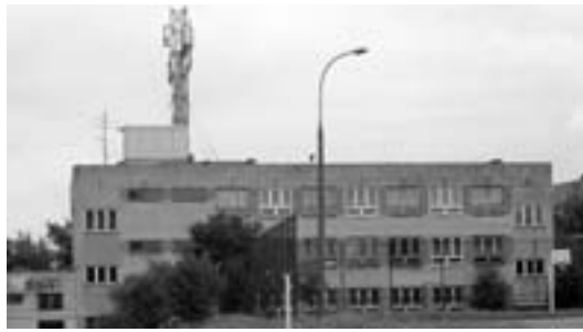
Na skutek protestu mieszkańców dyrektor Wydziału Edukacji UMK nie wyraził zgody na montaż dodatkowej anteny dla telefonii komórkowej oraz rozbudowę już istniejącej na dachu szkoły przy ul. Czarnogórskiej.
