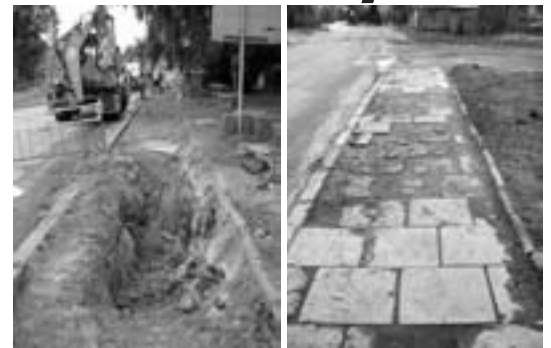
Ul. Łużycka na wysokości „studni miejskiej” w Piaskach Wielkich. Z lewej strony przyłącza wodociągowe, z prawej płyty chodnikowe przed ich zdjęciem.
