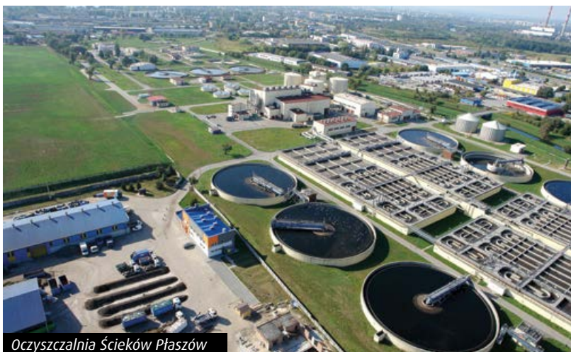
Oczyszczalnia Ścieków Płaszów
