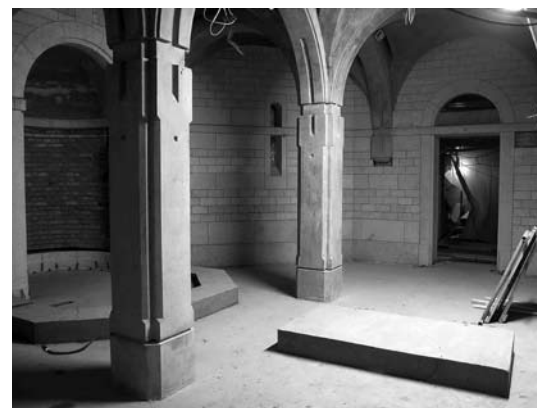
Wnętrze kaplicy kapłańskiej - widok na płytę fundamentową pod płytę nagrobną Jana Pawła II z Rzymu.
