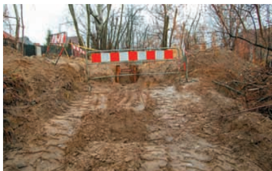
Budowa kanalizacji w ulicy Mokrej
