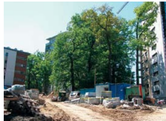
Trwa budowa os. Pod Dębami.
